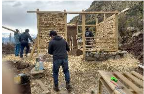
Figura 29. Proceso de construcción de caseta de acceso de quincha por Bioconstructora Cipreses.
