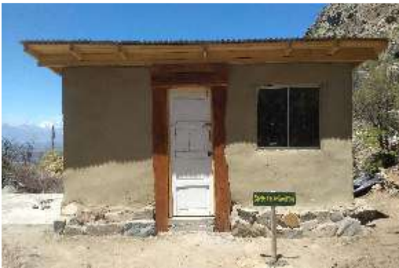
Figura 32. Caseta de Acceso o Control al Nuevo Centro de Reforestación y Bienvenida. Construida con quincha de barro y base de piedras del lugar, técnica de construcción ecológica empleada por la Bioconstructora Cipreses.
